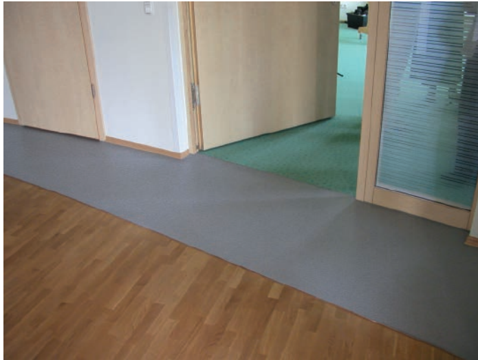
Starke Kontraste und Wechsel der Farbe, Muster und Materialien von Bodenbelägen können irritieren.
