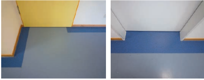
Farbkontraste können auch ganz bewusst als Bodenleitsysteme, hier z. B. rechts als Hemmschwelle oder links zur Erleichterung des Raumzutritts eingesetzt werden.
