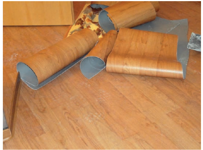
Designbodenverlegung im Pflegeheim: Sieht aus wie Holz, ist aber Vinyl.
